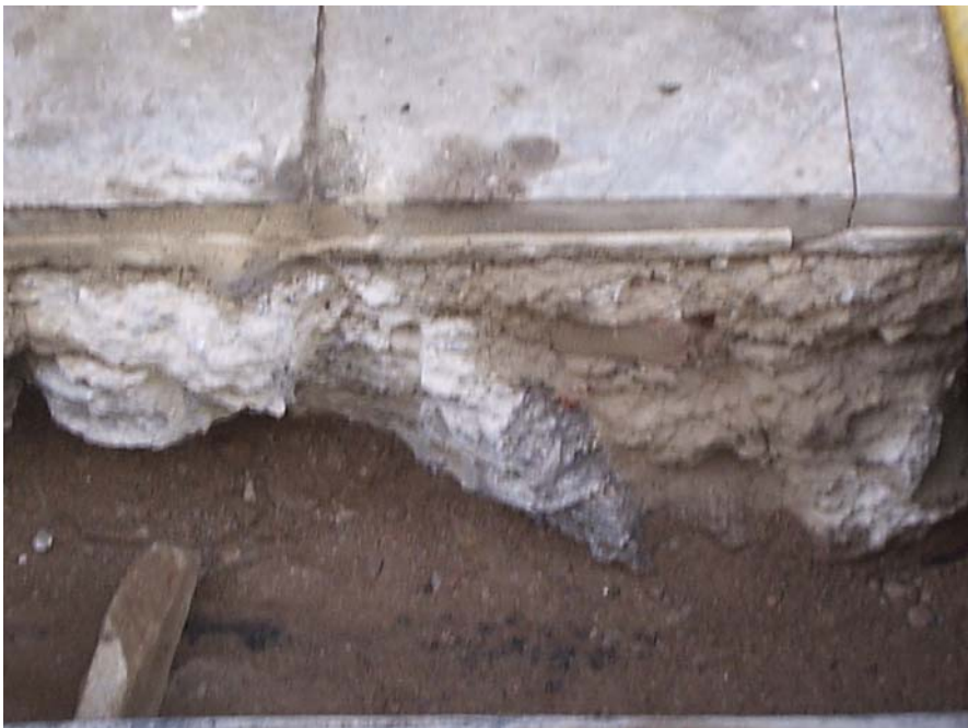
Perfil de la rasa on es veuen el paviment actual, la preparació de formigó i el sauló.
