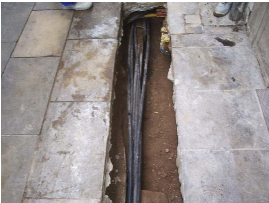
Rasa del carrer Ferran ja oberta amb els cables a la vista.
